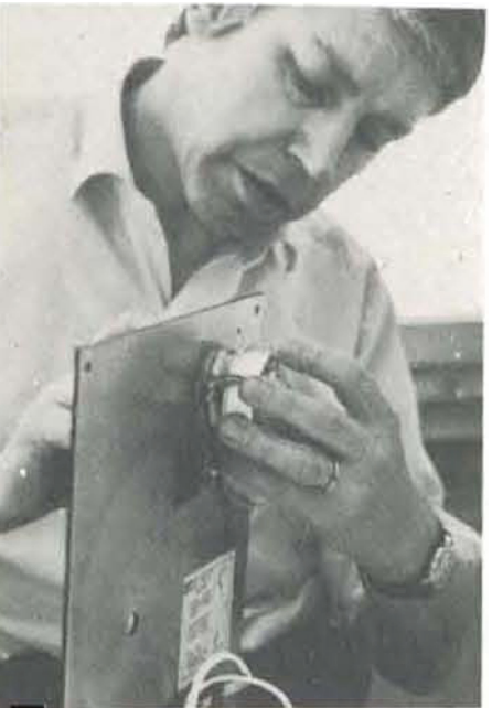
Så här ser den färdigkopplade skivspelaren ut underifrån. Observera jordningsförbindningen mellan motor och tonarmen.
