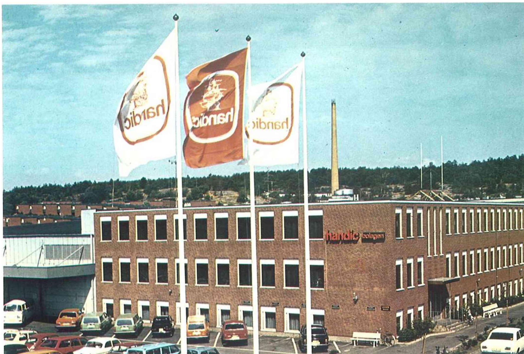
h a n d i c bolagens kontor, utvecklings- och serviceverkstad och lager i Västra Frölunda, Göteborg.
